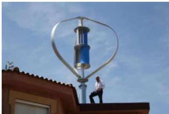
Los aerogeneradores de eje vertical no son afectados por la dirección del viento. Esto es útil en áreas donde el viento cambia de dirección rápidamente y constantemente.
